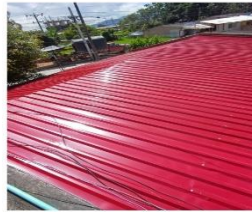
Ilustración 35 En la I.E.M Liceo Sur Andino, sede Jesús María Basto (comuna 3 centro), se realizó el cambio de cubierta de dos aulas
